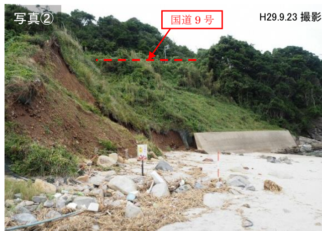
図 10.1.2 井手ヶ浜で発生した侵食による被災状況
