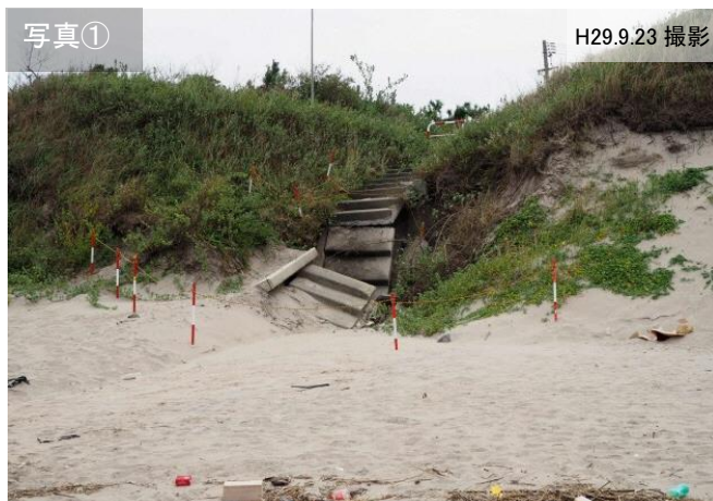
図 10.1.2 井手ヶ浜で発生した侵食による被災状況
